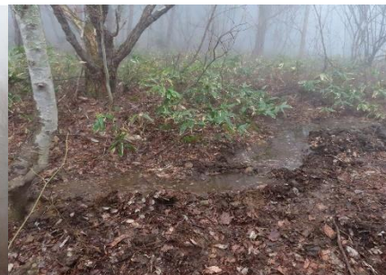
彩遊の森水場の補修
